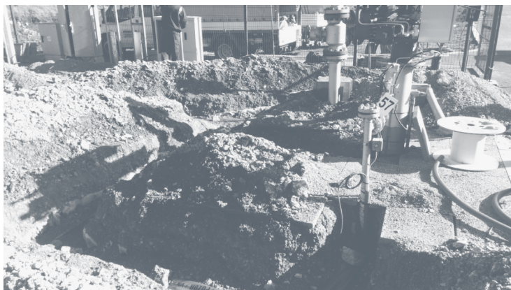
Izmještanje instrumentacije na MČS Rijeka istok
