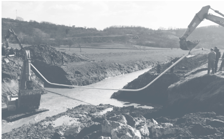
Popravak plinovoda DN 150 Dobrovac – Pakrac preko rijeke Pakre
