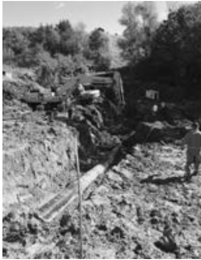
Plinovod Zabok-Ludbreg: demontaža postojeće cijevi na križanju s vodotokom Topličica
