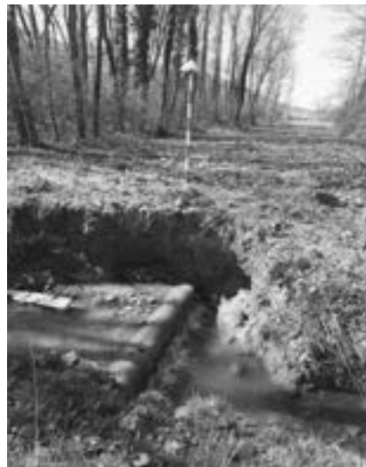
Plinovod Zabok-Ludbreg: otkrivena cijev na vodotoku Hruški Potok i postavljanje nove lire
